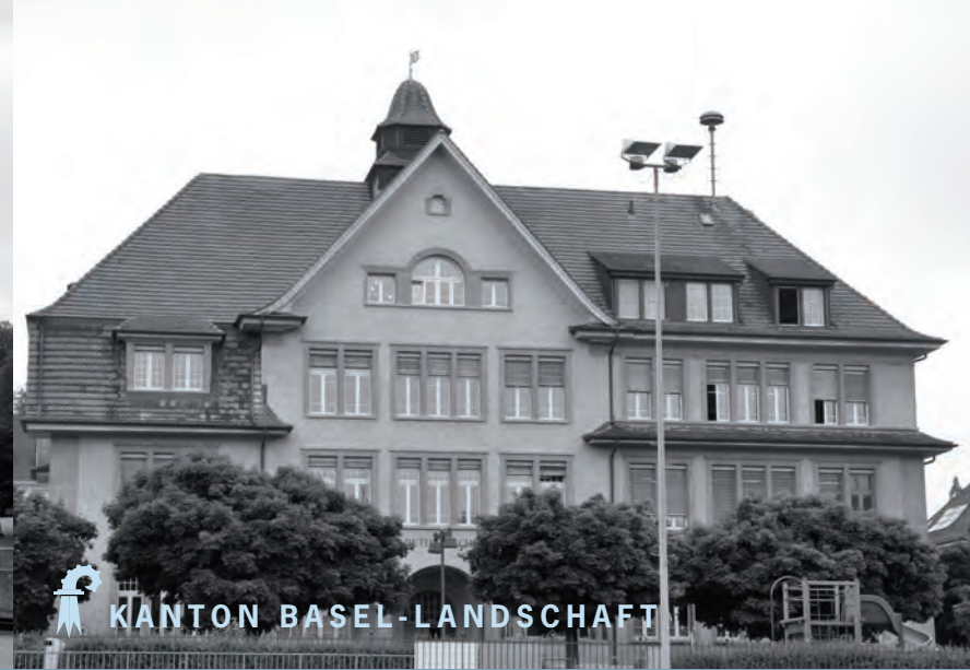
Schulhaus Spiegelfeld, Binningen
